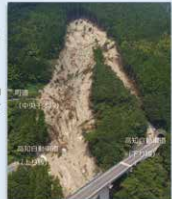
大豊町立川千本で発生した山腹崩壊（平成30年7月撮影）
