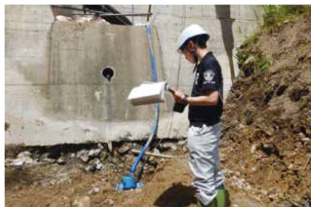
写真-4 現地確認の様子
