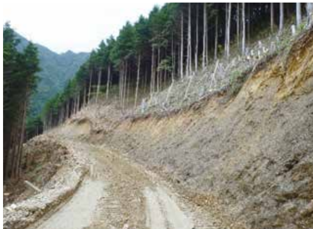
開設中の林道
