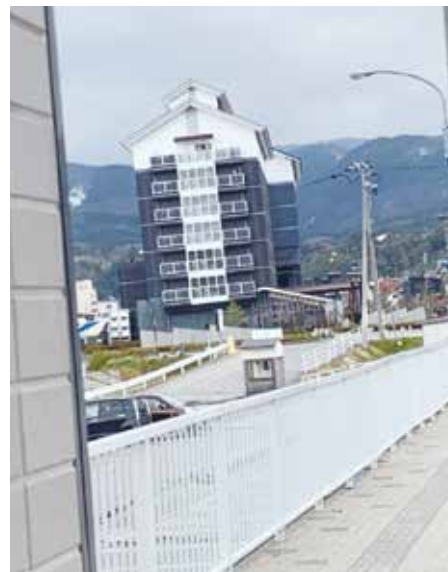
写真4 地盤の液状化で傾いた新しいホテル。背後のビルに対して約3度、海側へ傾動。現地では倒壊した古いビルも見されましたが、新しい基準で建造されたこのようなビルも複数傾いており、厚い砂地での「摩擦杭」が機能しなかった可能性があります。今後、現行の「建築基準法」の見直しが求められる可能性が高いと言えます。
