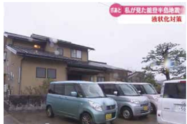
写真3 事前に液状化対策を行っていた木造家屋。家屋に目立った損傷はなく、地震後も住み続けている。内灘町西荒屋地区。（高知放送取材チーム撮影）
